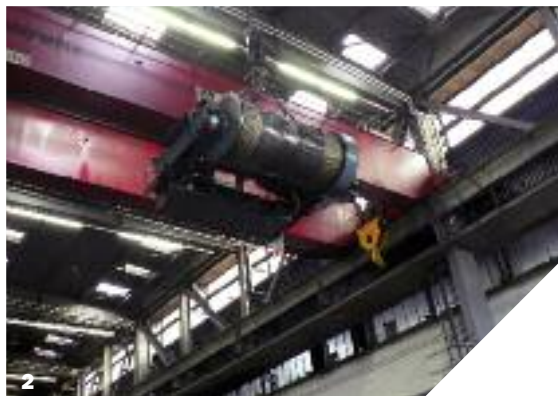
1 Die Ausgangssituation, 2 Demontage altes Hubwerk UNV10
